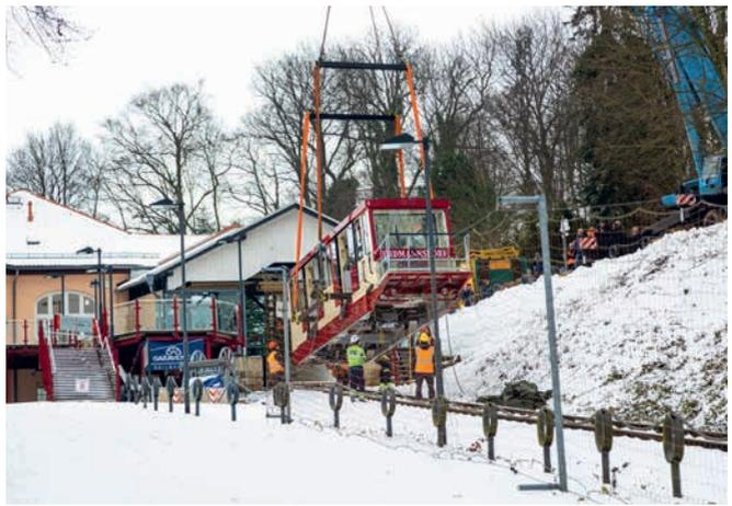
Die Karosserien der beiden Wagen erneuerten Experten einer Spezialfirma in Güstrow. Das Fahrwerk bekamen Eisenbahn-Spezialisten aus der Schweiz übertragen. Mit der Aufgleisung der Drahtseilbahn geht es auf die Zielgerade. Ab 21. März 2020 soll die „Alte Lady“ wieder sicher die Fahrgäste von der Talstation auf den Berg und umgekehrt bringen.
